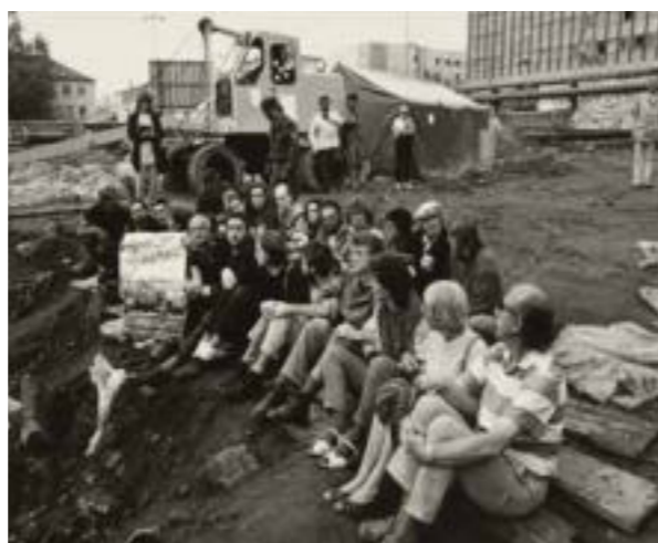
Demonstrant*innen besetzen die Baustelle der Stadtwerke, um die Überreste der Judengasse zu sichern.
